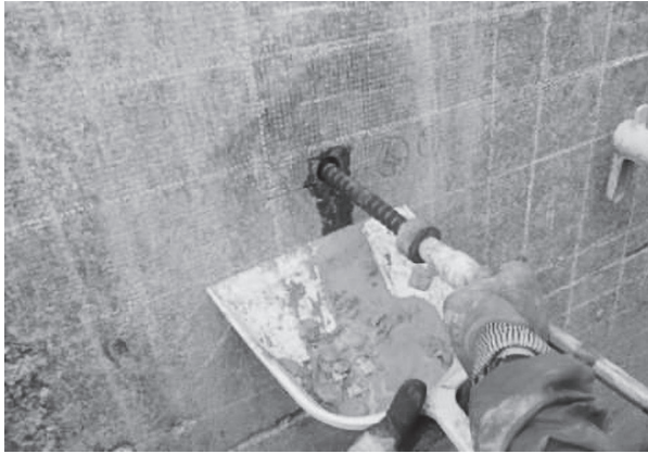
写真 11 堰柱耐震補強工（鉄筋挿入工法）
