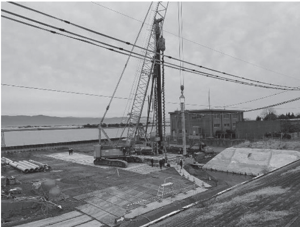
写真 14 基礎杭建込み（北新地排水機場）
