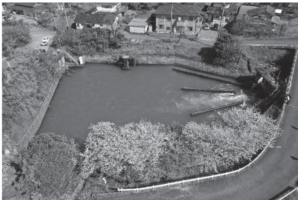
写真7 湾洞沈砂池(北岸導水路)(2023年3月) ※湾洞沈砂池から農業用水と水道水・工業用水に分水し、水道水の一部は上天草まで送水される
