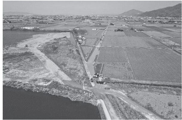
写真 15 流藻川排水機場搬入路設置工事状況 （2023年3月）
