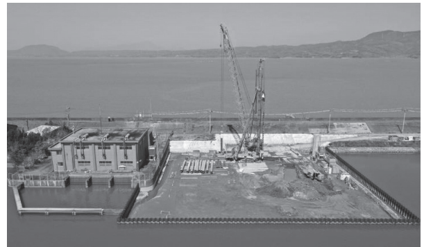
写真 12 北新地排水機場工事全景（2023年3月）
