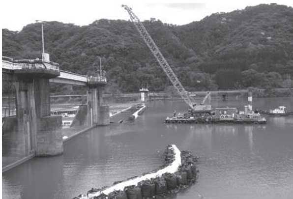
写真9 作業台船を用いた仮締切工
