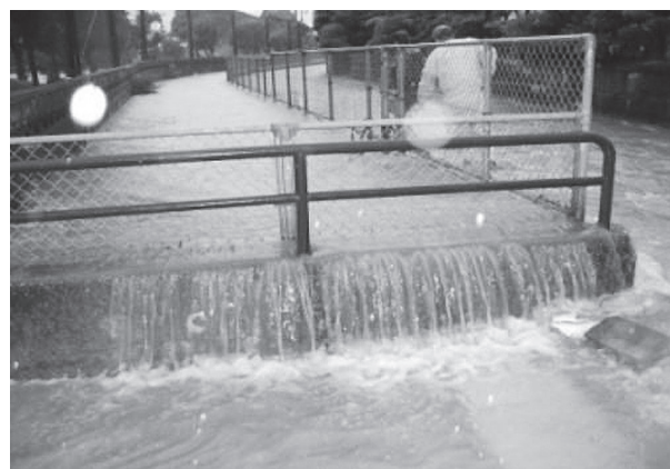
写真6 幹線水路からの溢水
